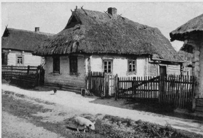
Abb. 22. UKRAINISCHER HAUSTYP aus dem südlichen Polessie. Borowno (P 42/S 40). Der fast quadratische geweißte Gebäudeteil der Wohnraum (izba). Anschließend daran — wie dies häufig bei polessischen Häusern der Fall ist — der erst später, gewissermaßen „ratenweise“ angebaute Vorhaus- und Speicherraum. Die restlichen Wirtschaftsgebäude schließen sich in gerader Flucht an (auf dem Bilde nicht sichtbar)
