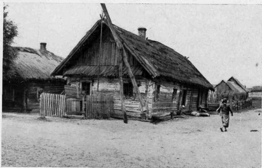
Abb. 19. WEISSRUSSISCHER HAUSTYPUS in Obrowo (Zajasioldzie P 38/S 41). Vorderer ge- weißter Teil Wohnraum (izba), hinterer Gebäudeteil Raum für Speicherzwecke und Hauswirtschaf- tsgesetz. Vor der Stirnfront des Hauses ein Ziehbrunnen
