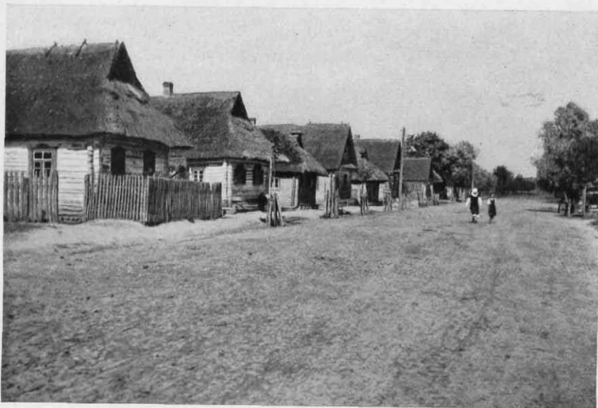
Abb. 27. SÜDPOLESSISCHES DORF, Tryputnia (P 42/S 42). Mischung von Häusern mit Vollwalm (ukrainisch bestimmte Form) und solchen mit Hochgiebel und hölzernem Fußwalm (weißrussisch beeinflusster Typus)
