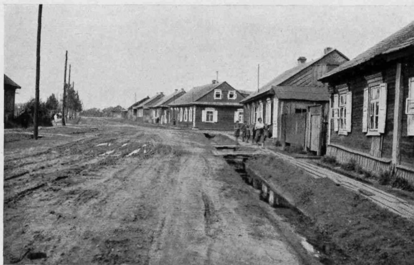
Abb. 36. STRASSE IN PIŃSK, unmittelbar an die Kernstadt anschließend mit jüdisch-landstädtischen Blockhausbauten. Unbefestigte Straße mit Wassergraben und hölzernem Laufsteg. Ein für alle polessischen Städte, auch Brest-Litowsk, kennzeichnendes Bild
