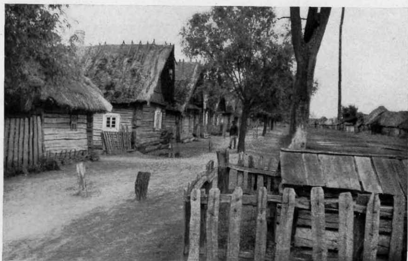
Abb. 20. DORF IM WEISSRUSSISCHEN SIEDLUNGSGEBIET Polessies namens Chwedry (Zarzewce P 41/S 43). Überwiegend Hochgiebel. Man beachte den geringfügigen Abstand zwischen den einzelnen Wohnhäusern, der verheerende Dorfbrände so sehr begünstigt. Rechts des anger- ähnlichen Dorftraktes die Wirtschaftsgebäude
