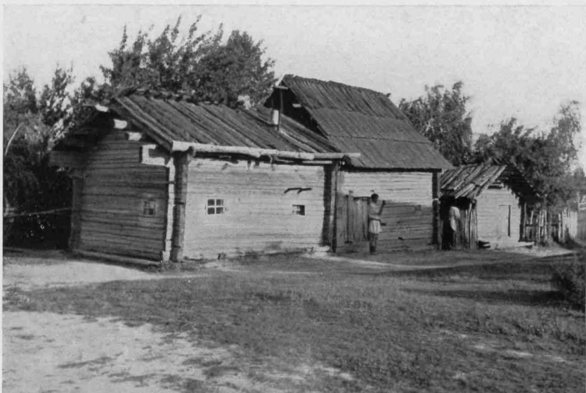
Abb. 18. AASERHAUS in Horodno (P 41/S 43). Älteste, heute mehr und mehr aussterbende und wahrscheinlich unter normannischem Einfluß entstandene Form des Blockbaus, die in dem slawischen Kulturcharakter Polessies wie ein Fremdkörper wirkt. Man achte auf das auf massigen Pfetten ruhende Bohlendach. Die Aaserhäuser sind weithin noch Rauchstubenhäuser. Rechts im Bilde der Getreide- und Leinenspeicher
