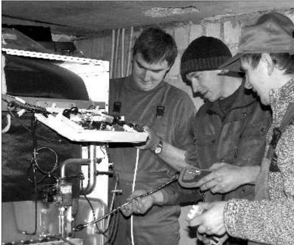
**БЕЗОПАСНОЕ ТЕПЛО.** Сервис котлов заключается, в основном, в контроле состояния токопроводящих частей и работы котловой автоматики. Фото: Игорь Вишняк
