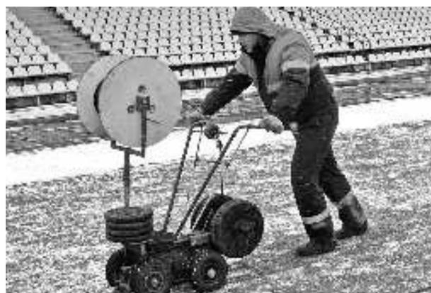
**ТЁПЛОЕ ПОЛЕ.** При помощи приспособления, похожего на плужок, роется бороздка глубиной 17 см, туда и укладывается кабель. Футбольное поле «Строителя» будет обогреваться при помощи 41 километра электрокабеля. Фото: Владимир Амелеченя
