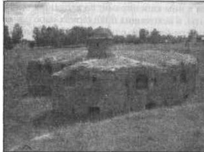
Крепость Бобруйск. Горжевой капонир редута рвов люнета с горжей, пятого полигона. Современное состояние. Сомкнутой оборонительной стенкой; из
