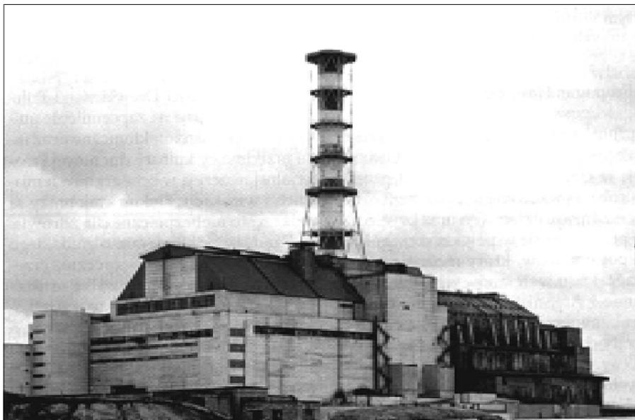
Сталёва-бетонны „саркафаг” Чарнобыльскай АЭС.
