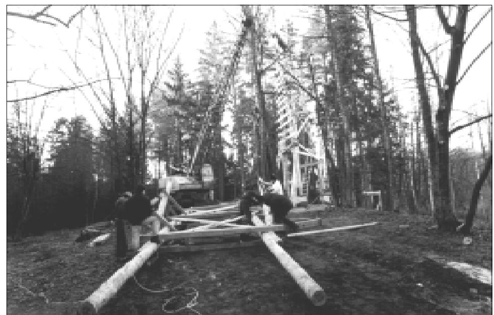
Зборка элементаў канструкцыі вышки.
